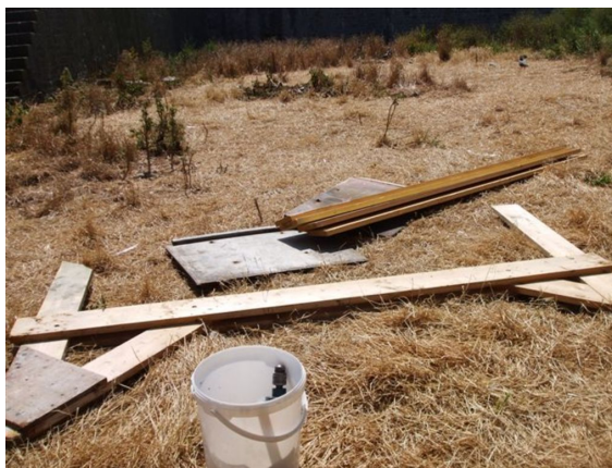
2013 : pose d'une passerelle provisoire en bois par l'entreprise Rigault
