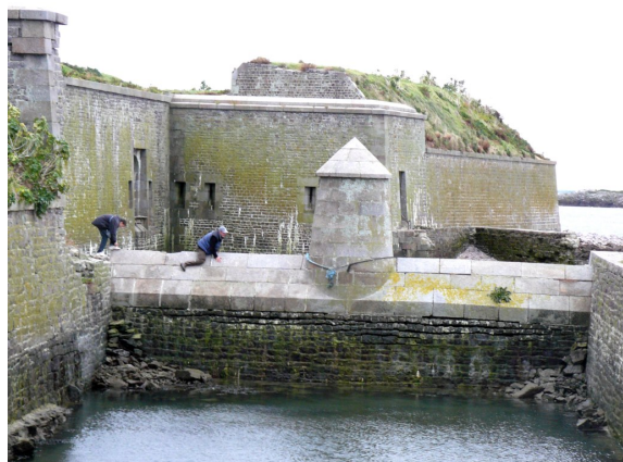
Avant 2013 : traversée manuelle sur le batardeau
